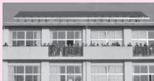
中学校屋上に設置された 太陽光発電パネル
