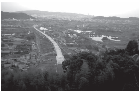
麻機遊水地第4工区
